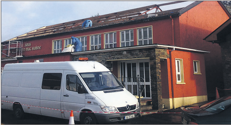
Saineolaithe aispeiste ag baint an chuid eile den díon de Halla Chúil Aodha an tseachtain seo
